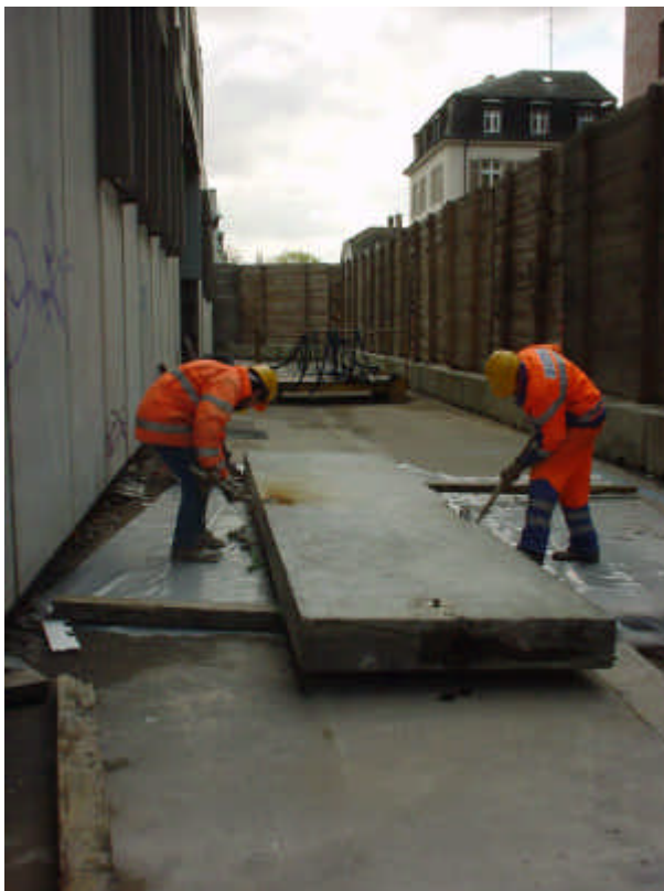
Abspachteln von PCB-haltigen Fugendichtungsmassen von einer Betonplatte
