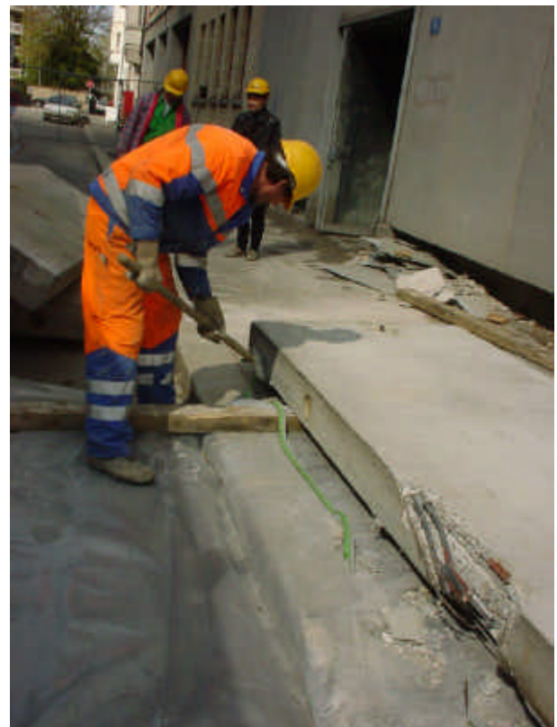
Abspachteln von PCB-haltigen Fugendichtungsmassen von einer Betonplatte
